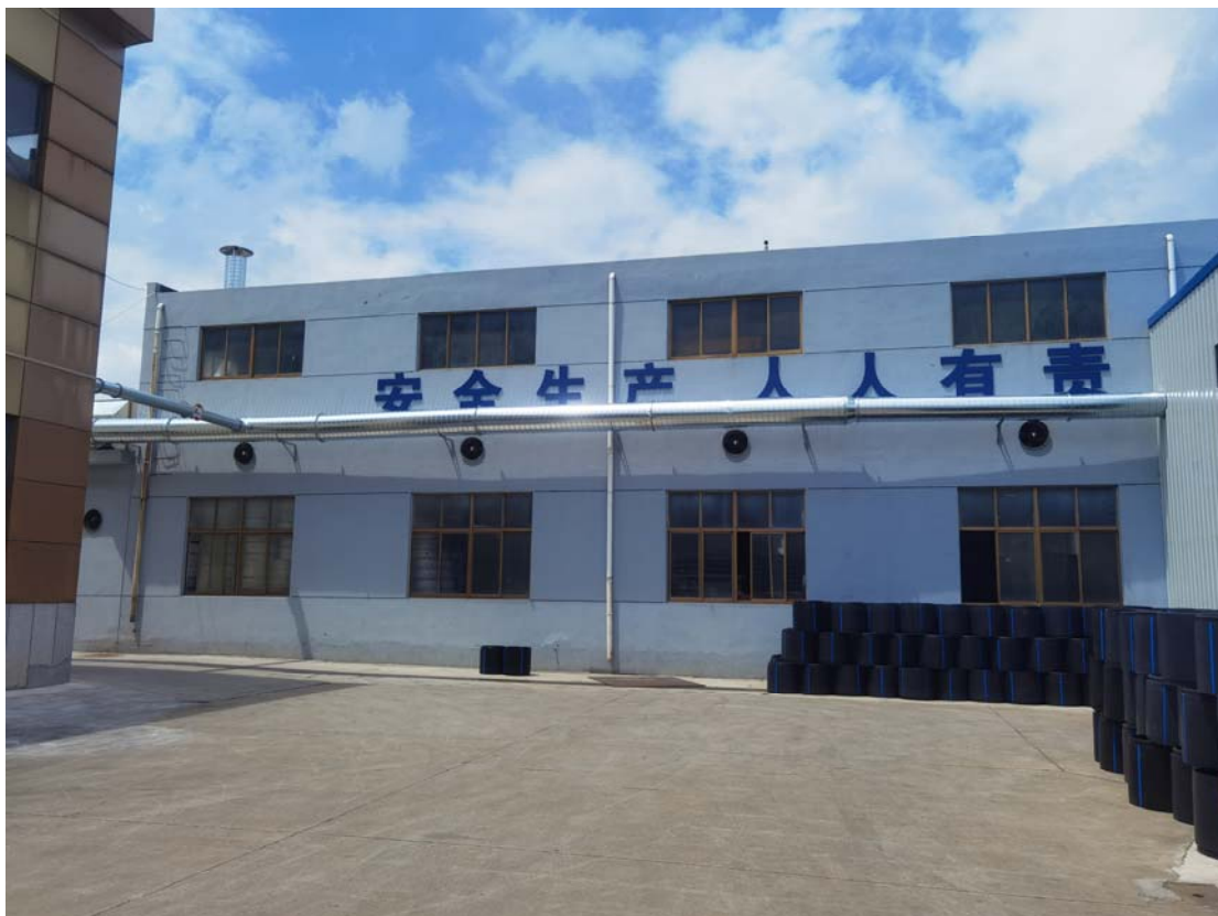
图 2-4 排气筒 DA002 相关车间收集管线
